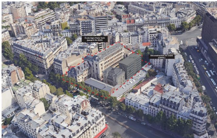
MABA - 15 AVENUE DU MAIN - ÉTAT EXISTANT
